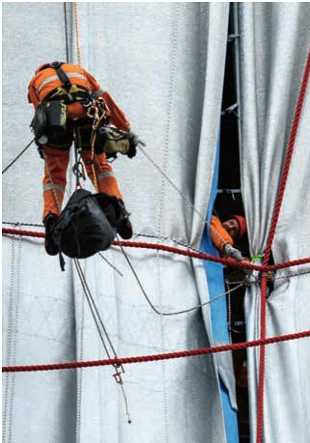
Industriekletterer können auch Kunst: Durch **«Knopflöcher» im Gewebe** werden die äusseren roten PP-Seile an der Unterkonstruktion befestigt.
